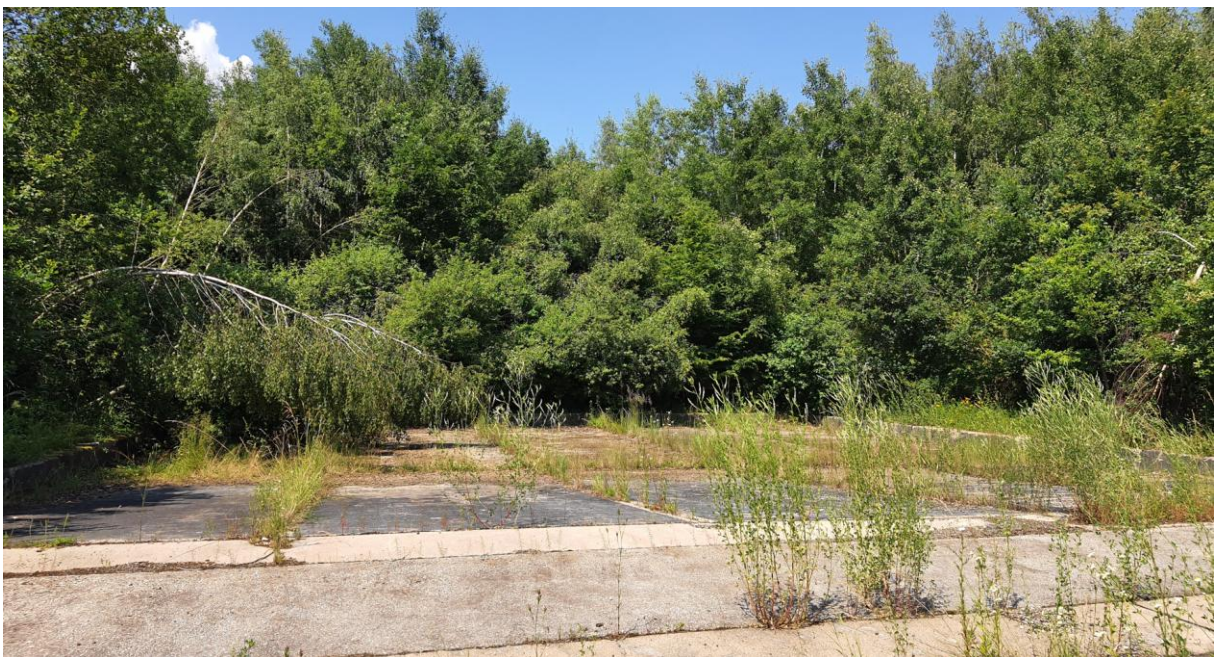
Abbildung 36: Betonbecken 4 mit wenig Vegetation, Jost 2024
