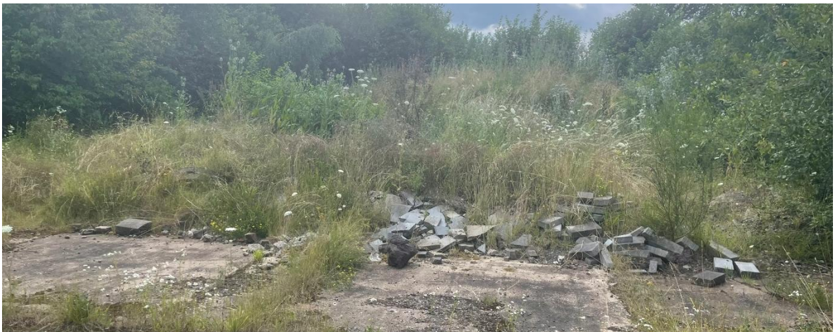
Abbildung 35: Betonbecken mit Erd-/Bauschuttmix, Kraus 2025
