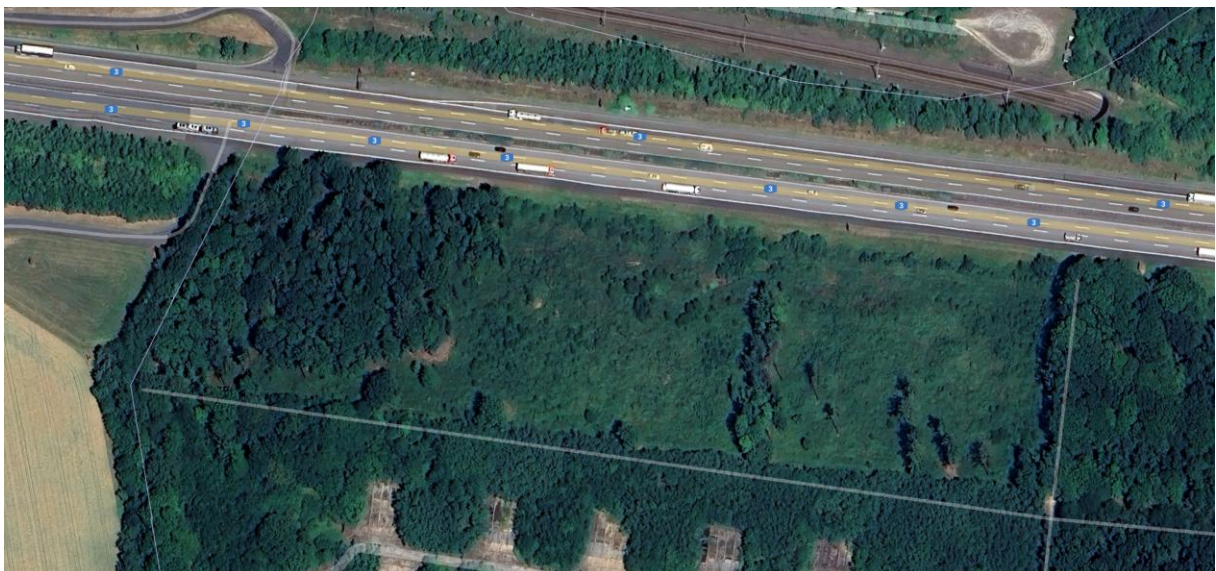
Abbildung 42: Luftbild Windwurffläche-Aufforstungsfläche Nadelwald, Google Earth 2025
