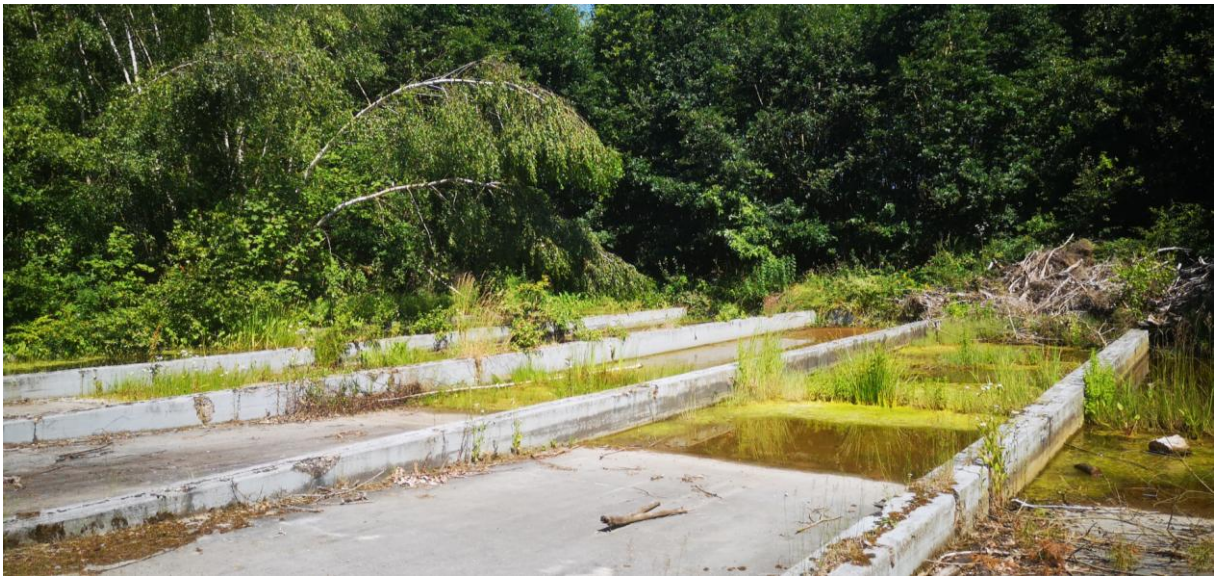
Abbildung 31: Betonbecken mit temporären Wassereinstau, Kraus 2024
