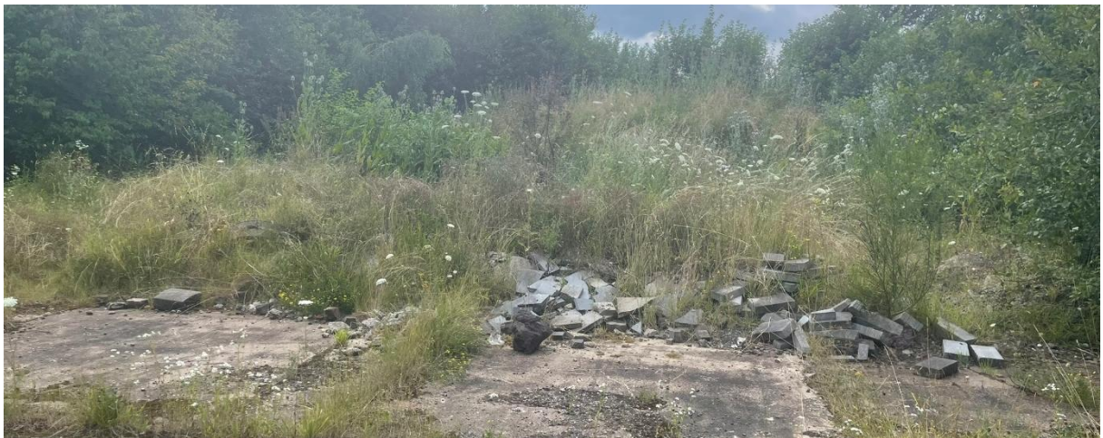
Abbildung 35: Betonbecken mit Erd-/Bauschuttmix, Kraus 2025
