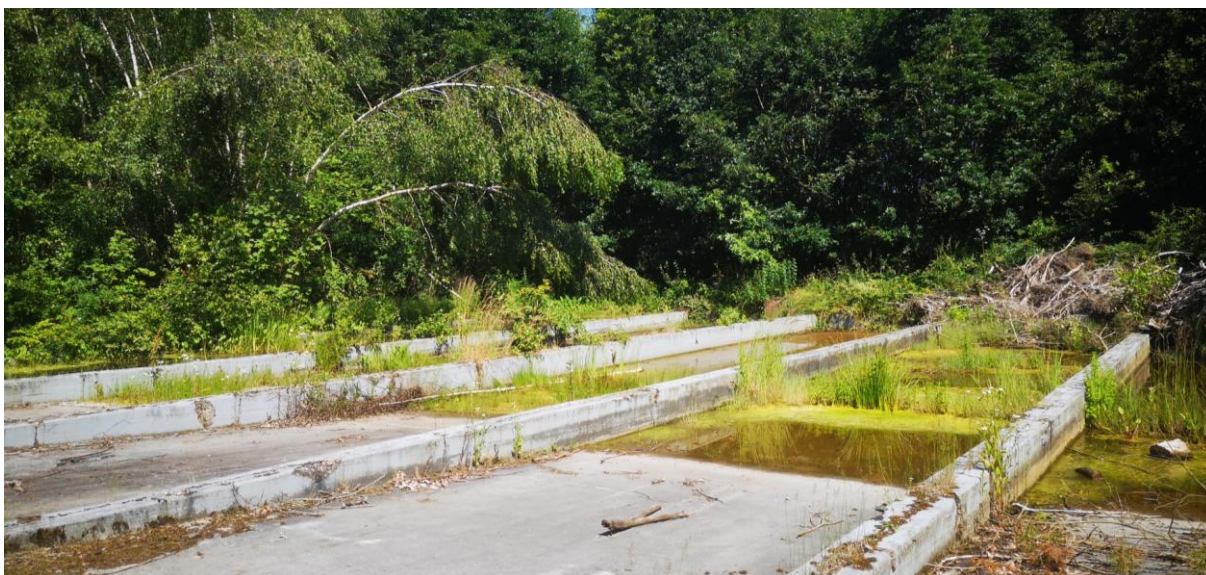
Abbildung 31: Betonbecken mit temporären Wassereinstau, Kraus 2024
