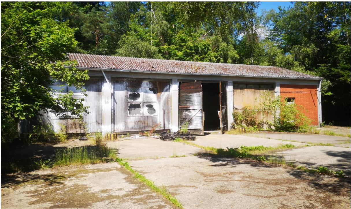
Abbildung 40. Ehemalige Halle für LKW + Brandschutzfahrzeuge, Kraus 2024
