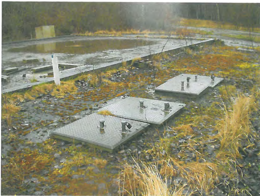
Bild 11: Östlicher Kanisterabfüllplatz mit Domschächten der Erdtanks (KVF021)
