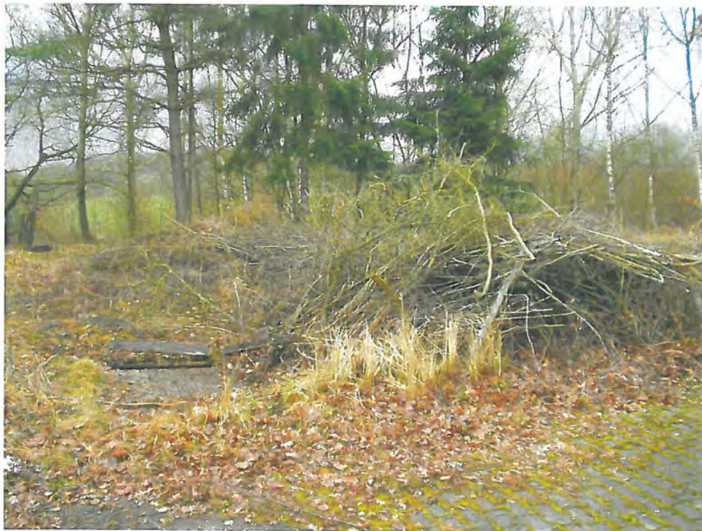
Bild 2: Abscheideranlage bei Verwaltungsgebäude (KVF026)
