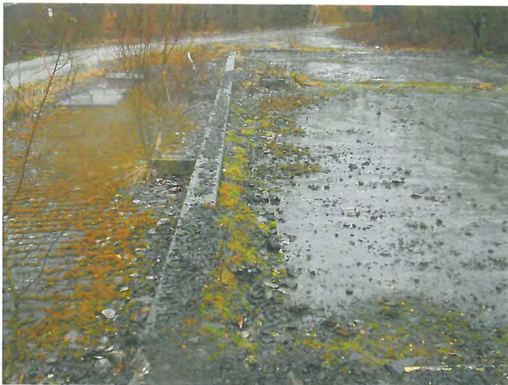
Bild 10: Westlicher Kanisterabfüllplatz mit Domschächten der Erdtanks (KVF020)
