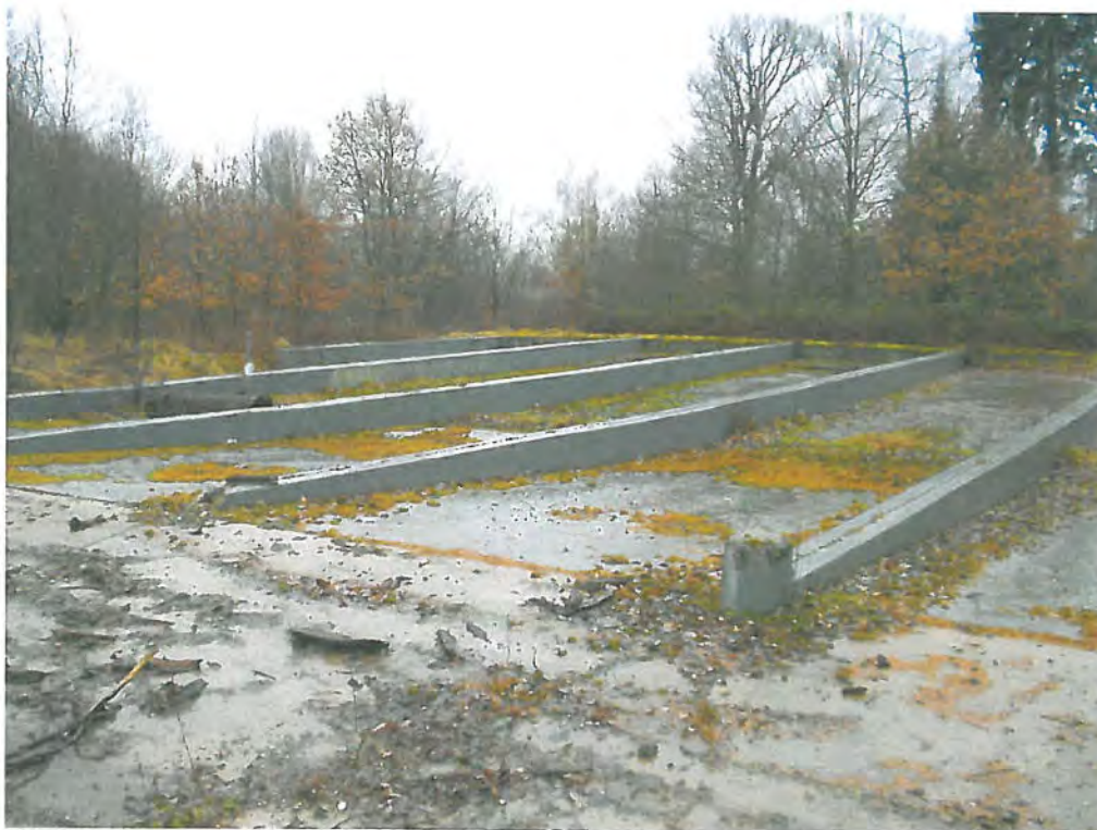
Bild 6: ehem. Kraftstofflager (KVF001 – KVF017)
