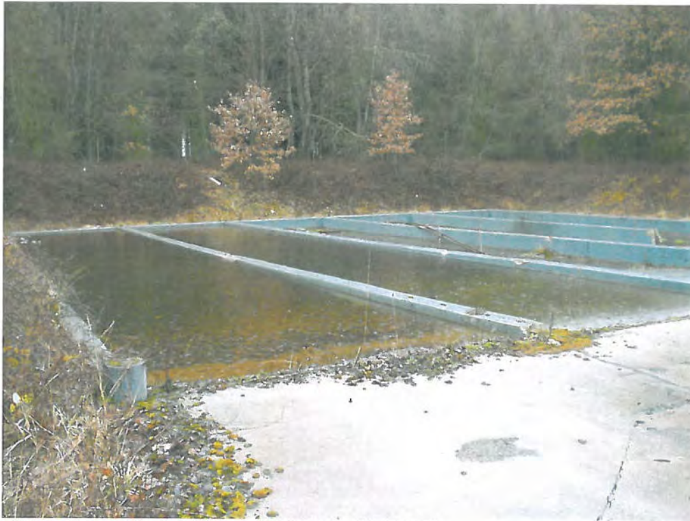
Bild 7: ehem. Kraftstofflager (KVF001 – KVF017)
