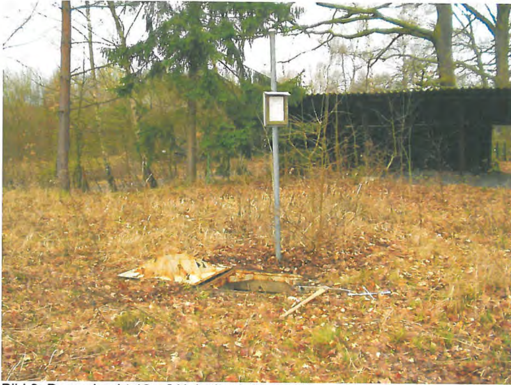
Bild 3: Domschacht 10 m 3 Heizöltank (KVF025)
