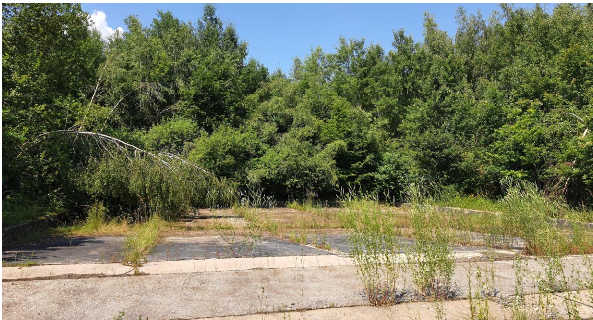
Abbildung 37: Betonbecken 4 mit wenig Vegetation, Jost 2024
