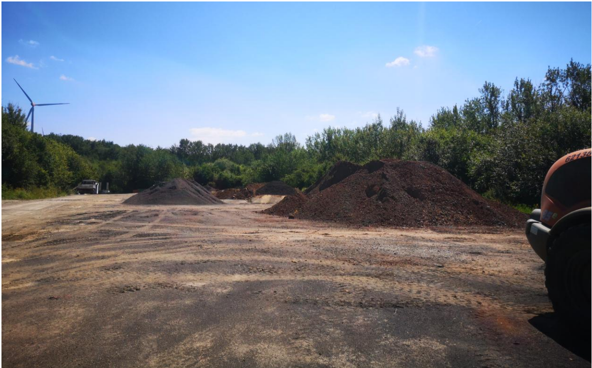
Abbildung 38: Schotter-/Lagerfläche im südlichen Bereich, Kraus 2024
