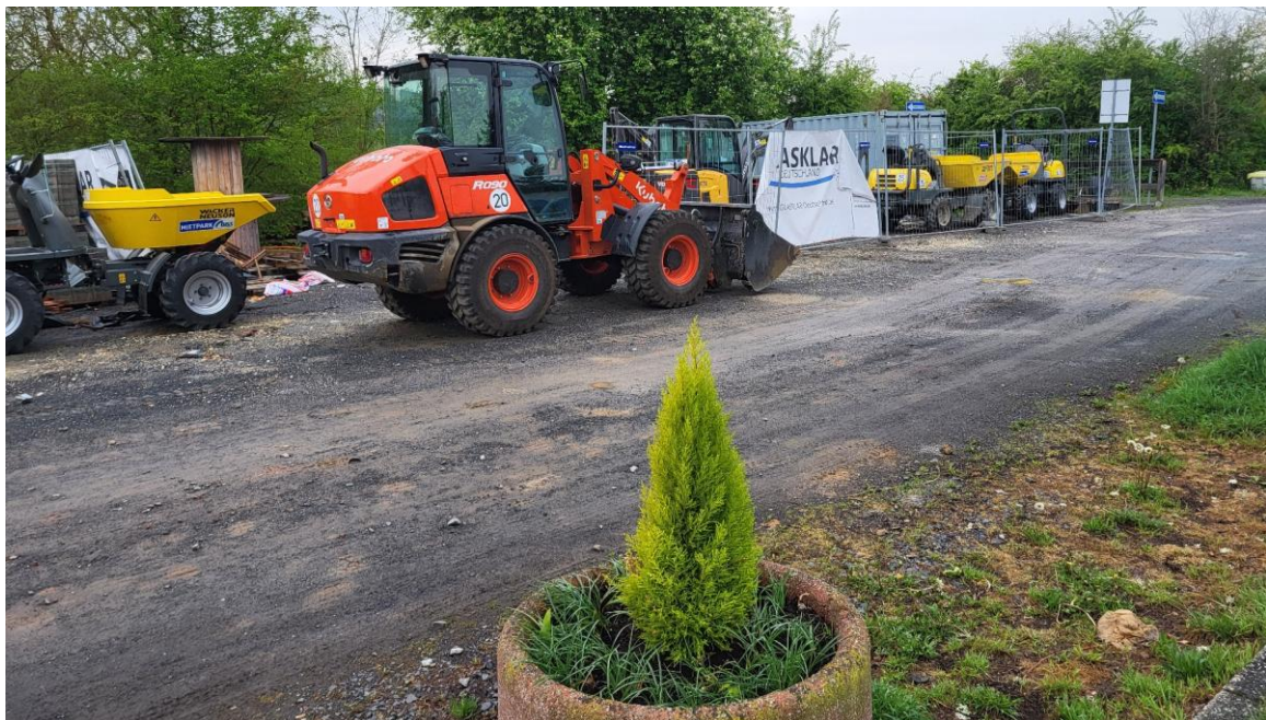
Abb. 7: Lagerplatz Glasfaserausbau, Gemeinde Elz 2025
