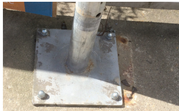
Abb. 6-12: Einbau mit Bodenhülse für befahrbare Flächen
