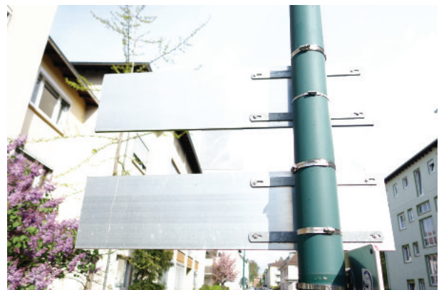
Abb. 6-4: Rückseitige Schildermontage
