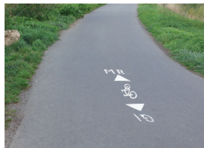
Abb. 4-17: Markierung mit Ortskennung im Flurbereich
