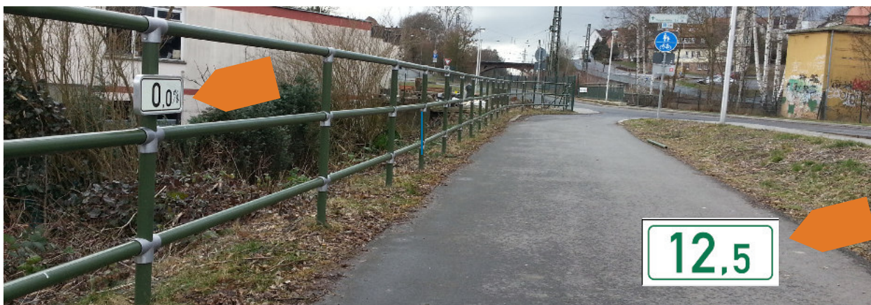
Abb. 4-14: Foto einer Stationierung mit Kilometerangabe
