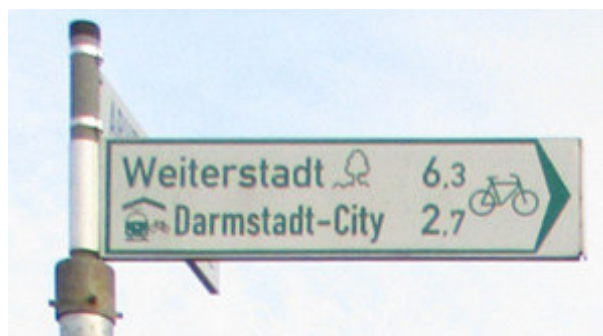
Abb. 6-6: Aufgesetzter Rohrfosten
