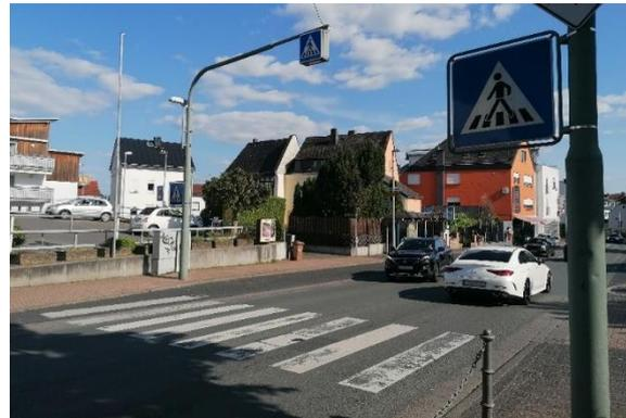
Der FGÜ ist nicht barrierefrei, da das Bord nicht komplett abgeflacht ist und sich auf den Gehwegen Engstellen befinden.
